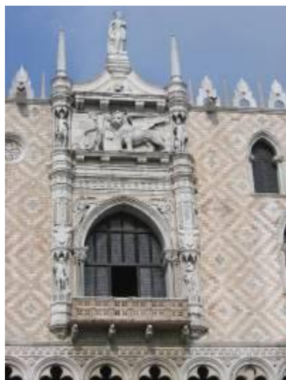
Figuur 28 Balkon westfaçade
