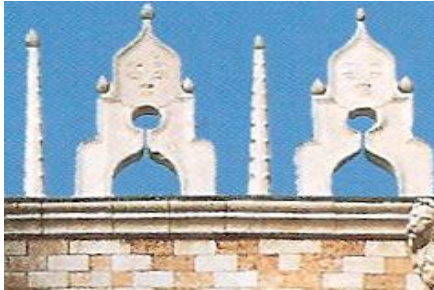
Figuur 17 Kantelen west- en zuidfaçade
