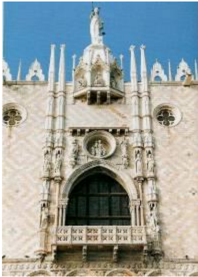
Figuur 27 Balkon zuidfaçade
